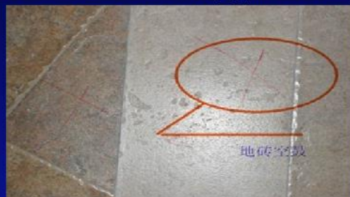
敲:对地面工程,装饰工程中的水磨石,面砖,石材饰面等敲击检查
