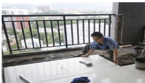
敲:对地面工程,装饰工程中的水磨石,面砖,石材饰面等敲击检查
