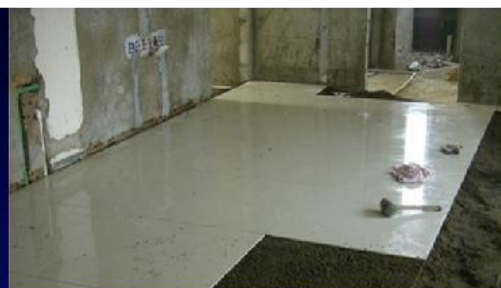
敲:对地面工程,装饰工程中的水磨石,面砖,石材饰面等敲击检查
