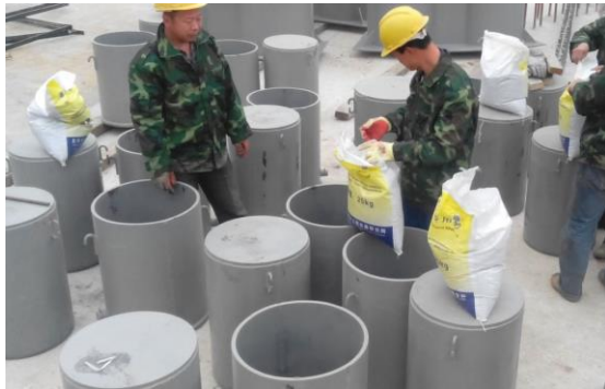
临时砂箱准备（采用零含水标准砂）
