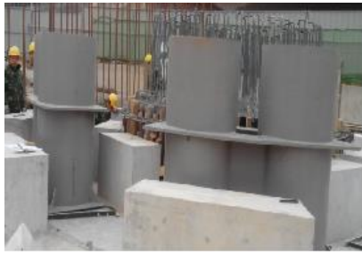
临时砂箱准备（采用零含水标准砂）
