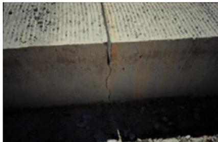
1.每日施工结束或因临时原因中断施工时，应设置横向施工缝，其位置应尽可能选在胀缝或
