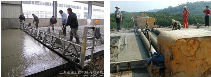
滑模式摊铺机直观图（履带内侧有挡板，充当模板）
