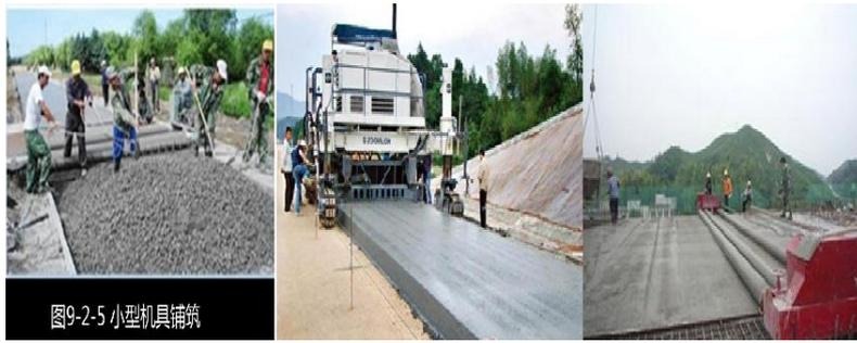
轨道式摊铺机（轨道充当模板，机械比较重，容易使路面变形）
