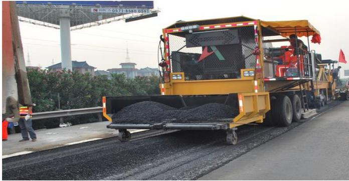
现场热再生中旧沥青混合料的加热重熔技术，新加沥青、再生剂与旧混合料的均匀复拌技术是关键问题，在施工工艺中应充分考虑加热设备和拌和摊铺设备的作业性能。
