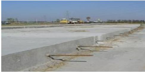
2.当一次铺筑宽度大于 4.5m 时，应设置纵向缩缝，构造可采用设拉杆假缝型，锯切的槽口深度应大于纵向施工缝的槽口深度。
