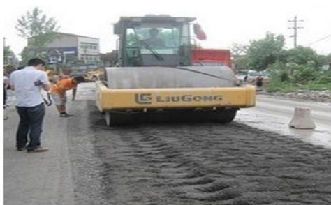
现场冷再生中关键技术是添加的胶粘剂（如乳化沥青、泡沫沥青、水泥）与旧混合料的均匀拌和技术，其余如旧沥青混合料的铣刨、破碎技术，胶粘剂配比性能也很关键。
