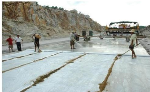
2.养护时间根据混凝土弯拉强度增长情况而定，不宜小于设计弯拉强度的 80%，应特别注重前 7d 的保湿（温）养护。一般养护天数宜为 14~21d，高温天不宜小于 14d，低温天不宜小于 21d。
