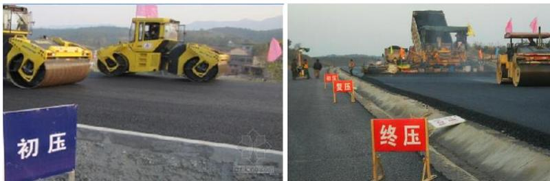
3.碾压顺纵向由低边向高边按规定要求的碾压速度均匀进行。相邻碾压重叠宽度大于30cm。
