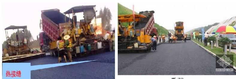
2.半幅施工不能采用热接缝时，采用人工顺直刨缝或切缝。铺另半幅前必须将边缘清扫干净，并涂洒少量粘层沥青。摊铺时应重叠在已铺层上 5~10cm，摊铺后将混合料人工清走。碾压时先在已压实路面行走，碾压新铺层 10~15cm，然后压实新铺部分，再伸过已压实路面 10~15cm，充分将接缝压实紧密。
