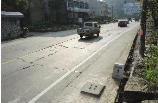
2.对发生错台或板块网状开裂，应首先考虑是路基质量出现问题，必须将整个板全部凿除，重新夯实路基及基层，浇筑同强度等级混凝土，传力杆按原水泥混凝土面板的设置情况进行设置。
