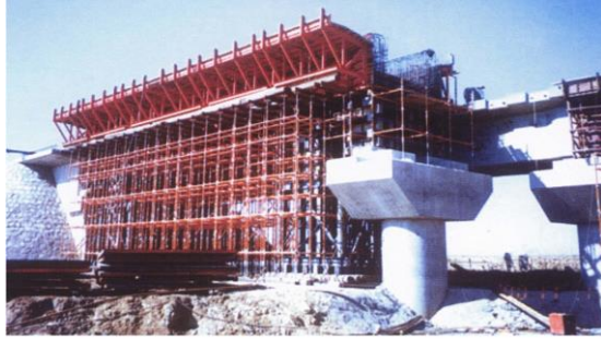
秦沈线上采用的碗扣支架
