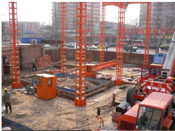
第一步：锁口圈梁施工
