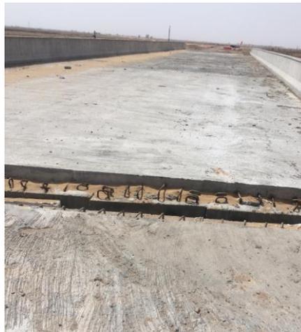
桥头搭板：防止路桥交接处的沉降，在桥台和填土之间，车辆行驶有一个缓冲作用
