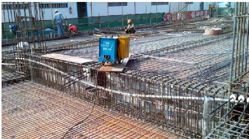
南京长江三桥引桥的连续梁箱梁底板及腹板塑料波纹管的安装。
