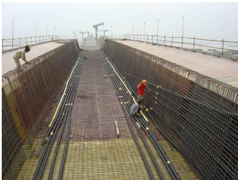
南京长江三桥引桥的连续梁箱梁底板及腹板塑料波纹管的安装。
