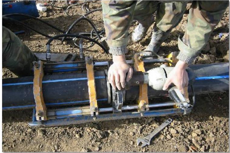
图1K416013 HDPE管焊接施工工艺流程图
