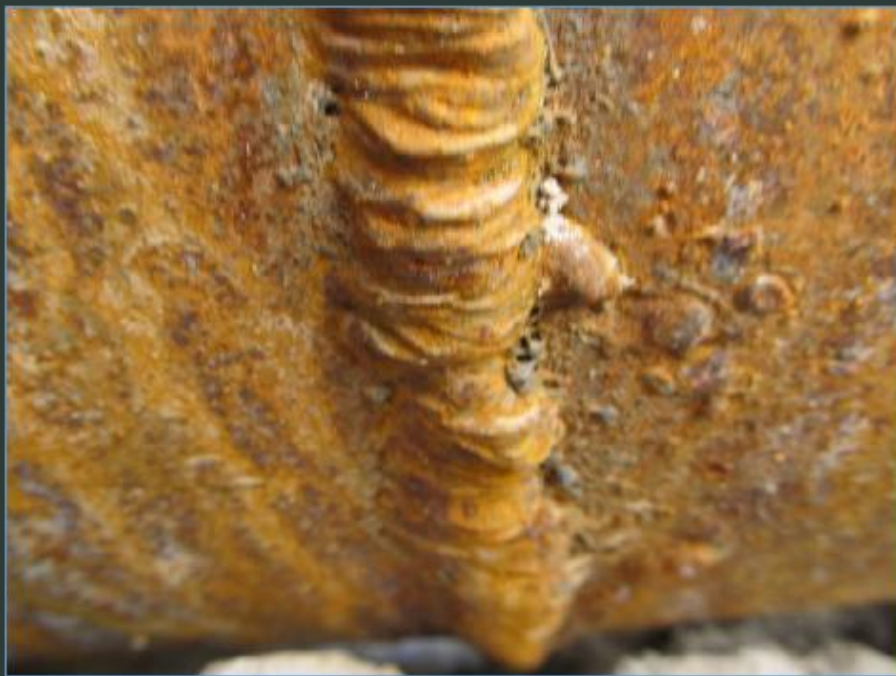
焊缝存在夹渣、气孔、裂纹
