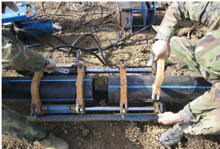
②固定PE管
