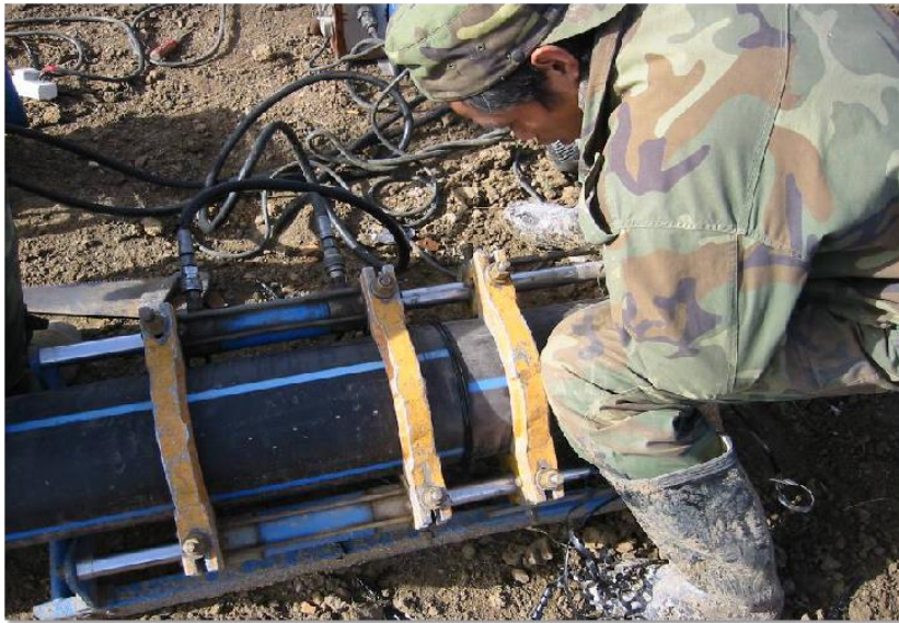
⑦挤压对接
