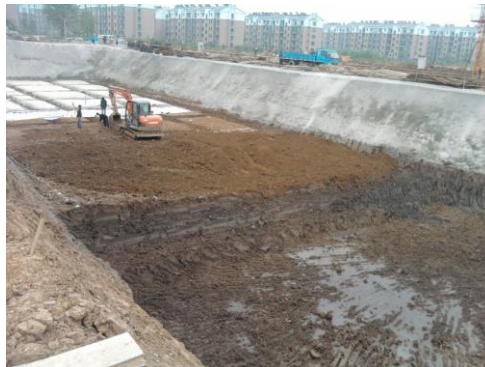
超挖 (150mm) 扰动、受水浸泡 (伤口较深, 100-300mm)
