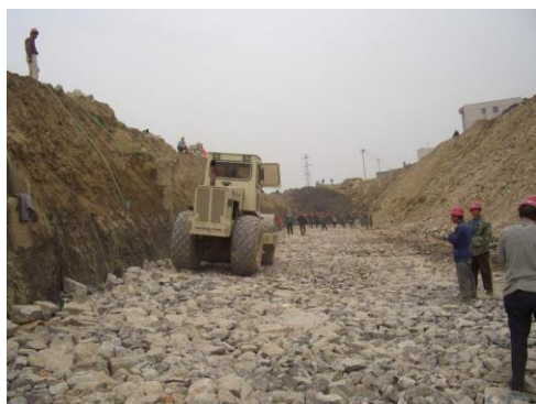
槽底局部扰动、受水浸泡 (表皮受伤, 100mm内)
