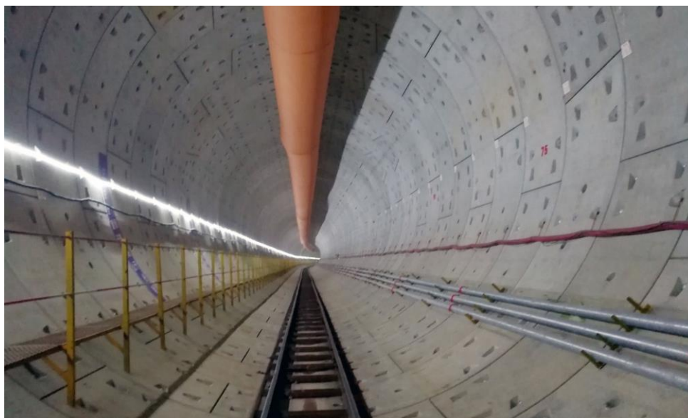
图1K413012-2 盾构法施工示意图
