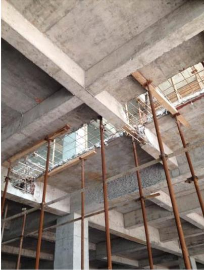
(2)模板接缝处应严密平整，变形缝止水带安装符合设计要求。
