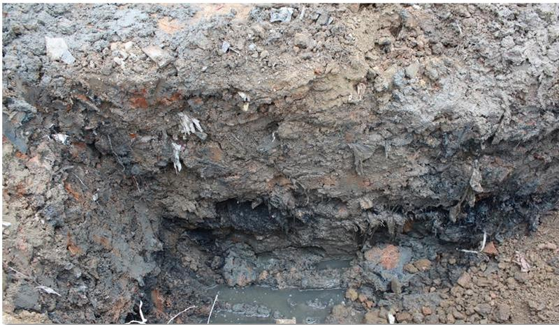
(2) 不应使用淤泥、沼泽土、泥炭土、冻土、盐渍土、腐殖土、有机土及含生活垃圾的土做路基填料。填土内不得含有草、树根等杂物, 粒径超过 100mm 的土块应打碎。
