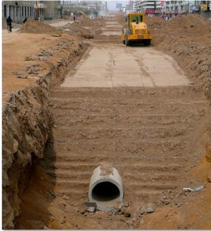
(2) 当管道结构顶面至路床的覆土厚度不大于 500cm 时，应对管道结构进行加固。
