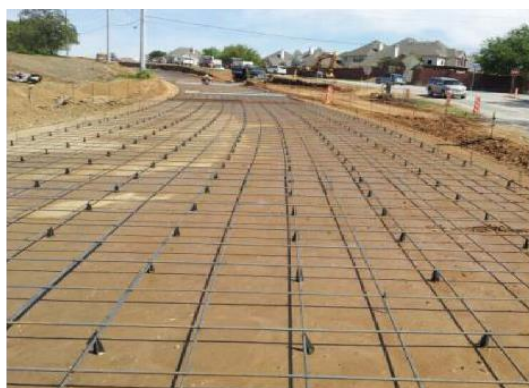
◀ 连续配筋混凝土板
