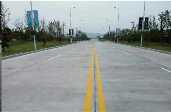
水泥混凝土路面
