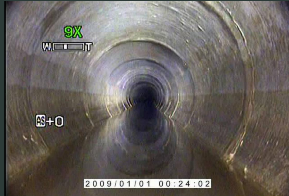
( 中央控制工业管道内窥摄像 )
