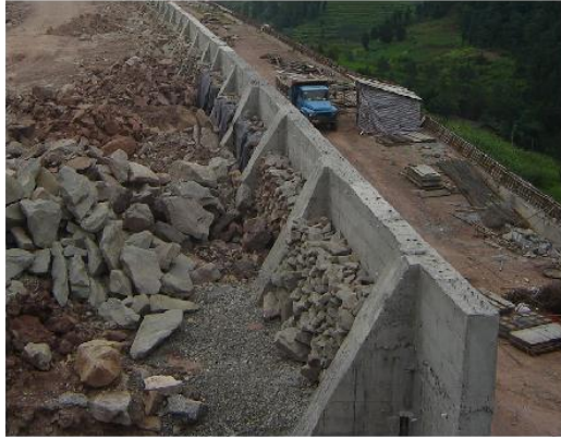
钢筋混凝土扶壁式
