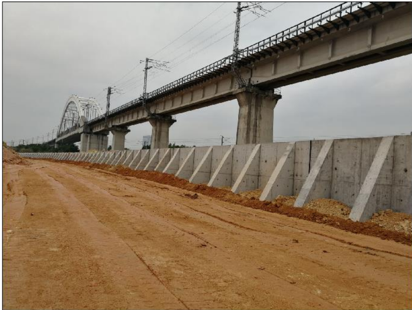
钢筋混凝土扶壁式
