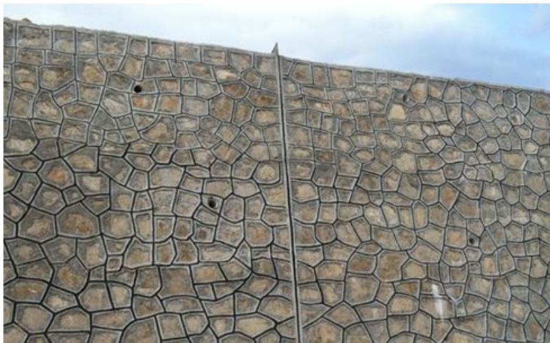
沉降缝与伸缩缝的布置形式
