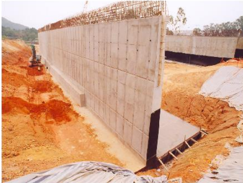
钢筋混凝土悬臂式
