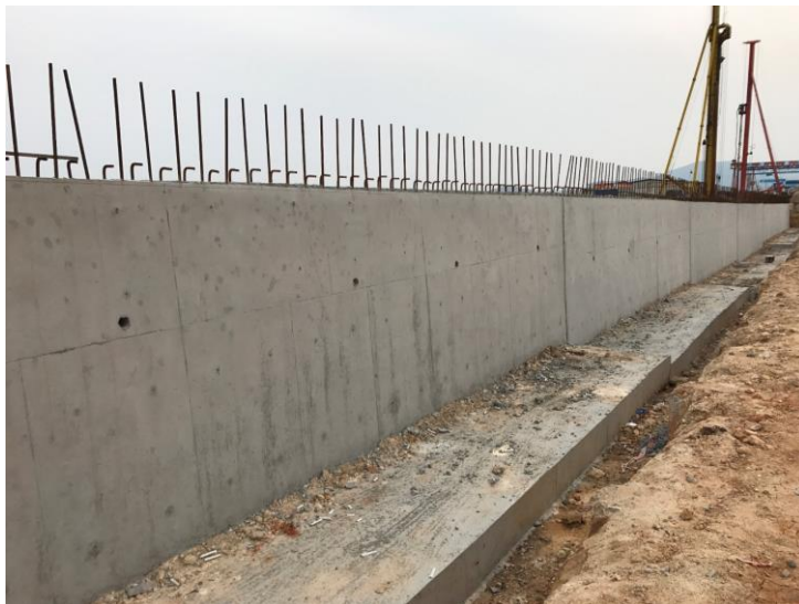
钢筋混凝土悬臂式
