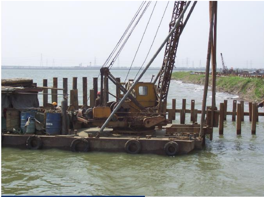
木桩（钢桩）复合土围堰
