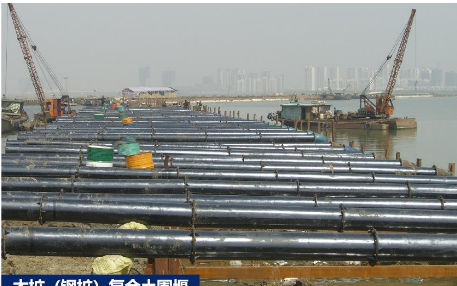
木桩（钢桩）复合土围堰
