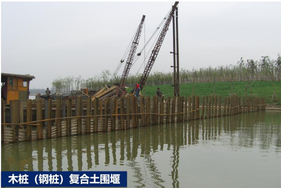
木桩（钢桩）复合土围堰
