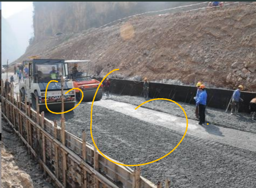
碾压混凝土板
