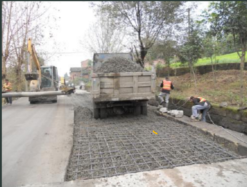
钢筋混凝土板
