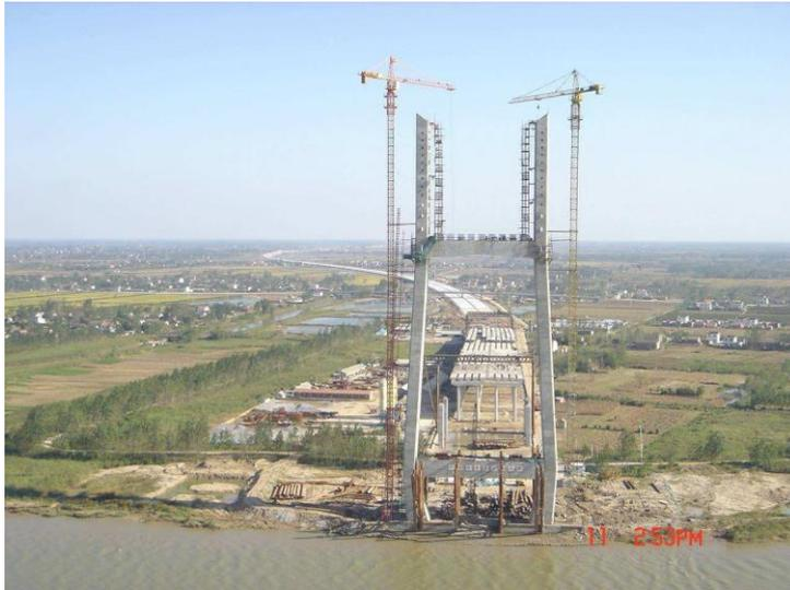
3) 倾斜式索塔施工时，必须对各施工阶段索塔的强度和变形进行计算，应分高度设置横撑，使其线形、应力、倾斜度满足设计要求并保证施工安全。
