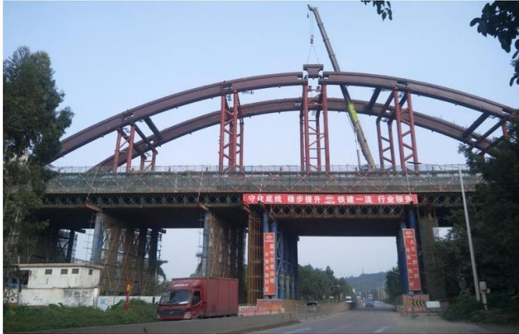
(4) 拱圈（拱肋）封拱合龙温度应符合设计要求，当设计无要求时，宜在当地年平均温度或  $5 \sim 10^{\circ}\text{C}$  时进行。
