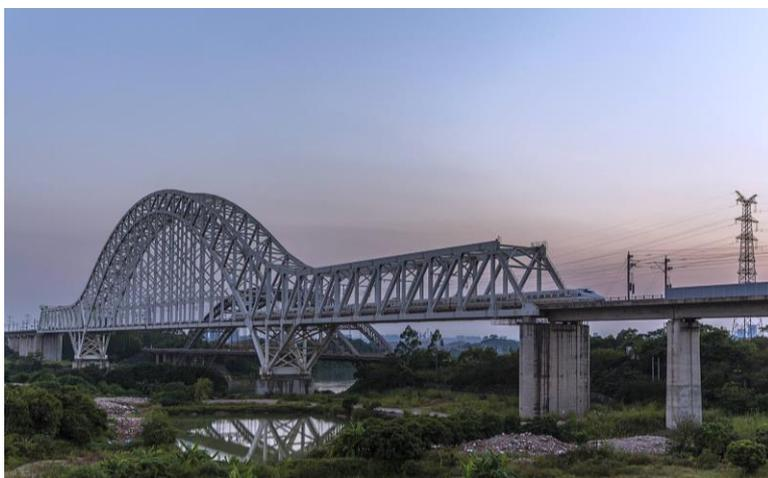
(3) 安装过程中应采用全站仪, 对拱肋、拱圈的挠度和横向位移、混凝土裂缝、墩台变位、安装设施的变形和变位等项目进行观测。
