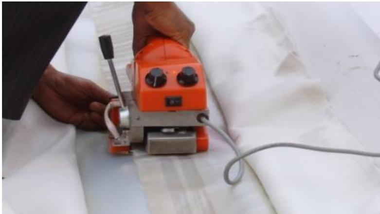
(4)防水卷材固定在初期衬砌面上；采用软塑料类防水卷材时，宜采用热焊固定在热圈上。
