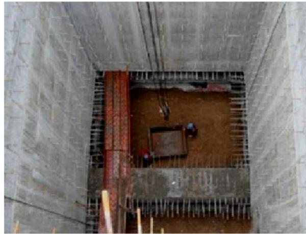
(4) 钢筋混凝土底板施工前，井内应无渗漏水，且新、老混凝土接触部位凿毛处理，并清理干净。
