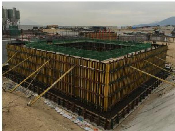
(6) 池壁与顶板连续施工时，池壁内模立柱不得同时作为顶板模板立柱。顶板支架的斜杆或横向连杆不得与池壁模板的杆件相连接。池壁模板可先安装一侧，绑完钢筋后，分层安装另一侧模板（内模一次支好，外模随支随浇，否则高池壁混凝土浇筑、振捣均困难），或采
