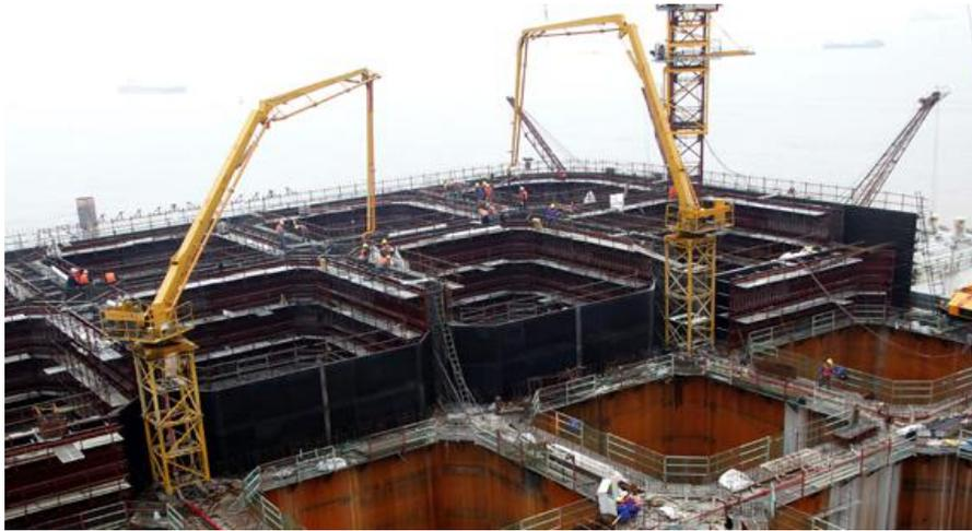
(7) 水下封底混凝土强度达到设计强度等级,沉井能满足抗浮要求时,方可将井内水抽除,并凿除表面松散混凝土进行钢筋混凝土底板施工。
