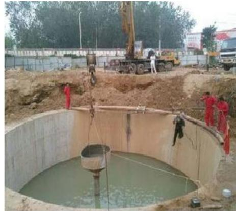
(4) 浇筑前, 每根导管应有足够的混凝土量, 浇筑时能一次将导管底埋住。
