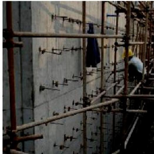
②墙体遇水或在地下（有止水要求）：采用带止水片（止水环）的对拉螺栓，即止水螺栓。
