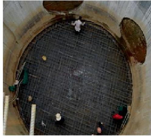
(5) 封底前应设置泄水井, 底板混凝土强度达到设计强度等级且满足抗浮要求时, 方可封填泄水井、停止降水。
