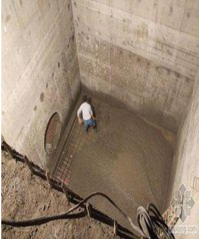
(3) 采用全断面封底时，混凝土垫层应一次性连续浇筑；有底梁或支撑梁分格封底时，应对称逐格浇筑。
