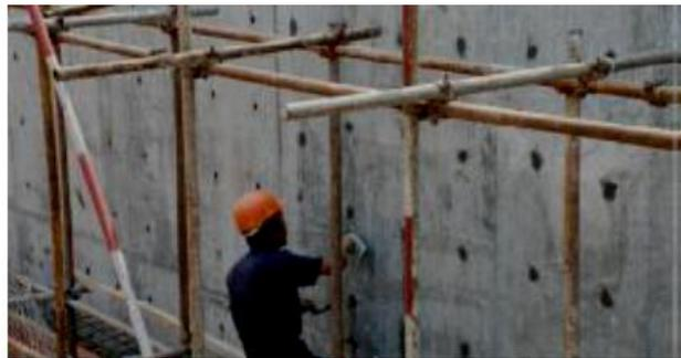
B.新型：止水螺栓可部分拔出再利用，螺栓孔用防水砂浆填塞。
