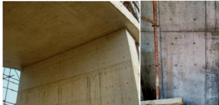
②墙体遇水或在地下（有止水要求）：采用带止水片（止水环）的对拉螺栓，即止水螺栓。
