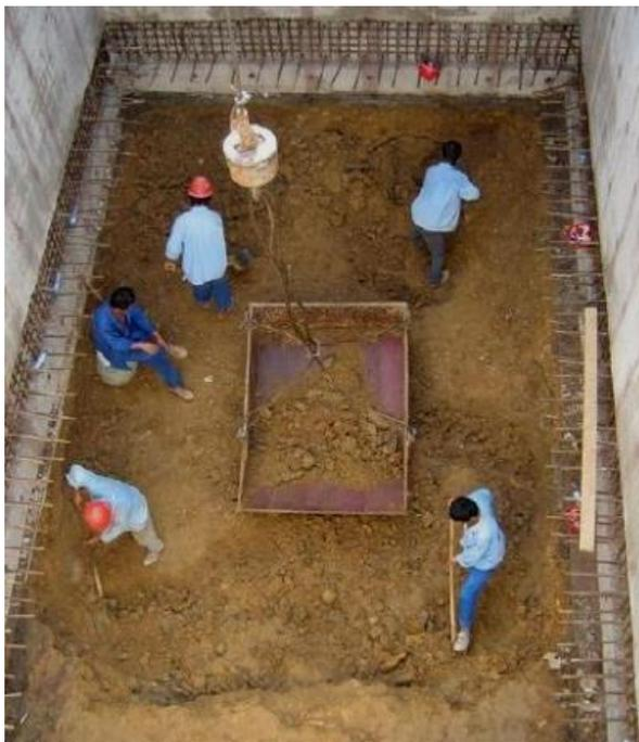
(1) 在井点降水条件下施工的沉井应继续降水，并稳定保持地下水位距坑底不小于 0.5m；
