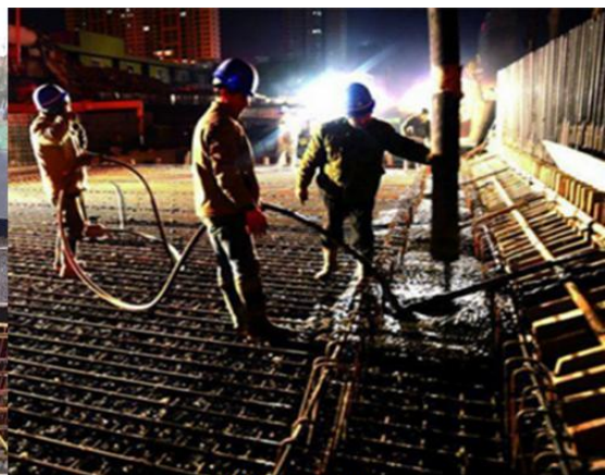
混凝土浇筑
