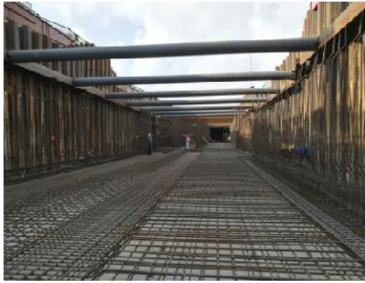
管廊钢筋绑扎
