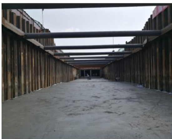
混凝土垫层施工
