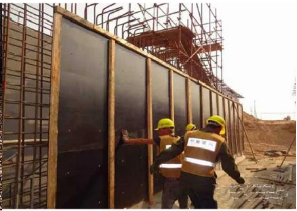
内侧墙模板支设
