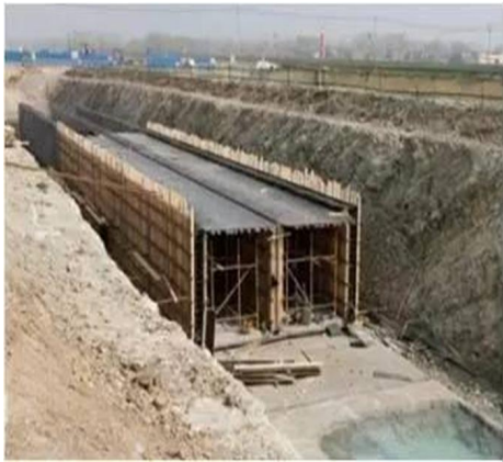
现浇混凝土综合管廊施工 ( 9 ):
