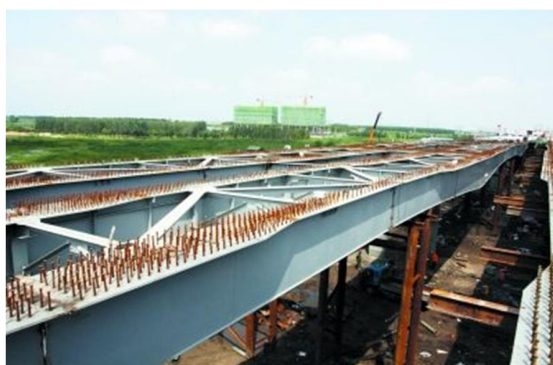
图 1.14 高强度螺栓连接件
