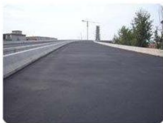
养护中的桥面防水层
