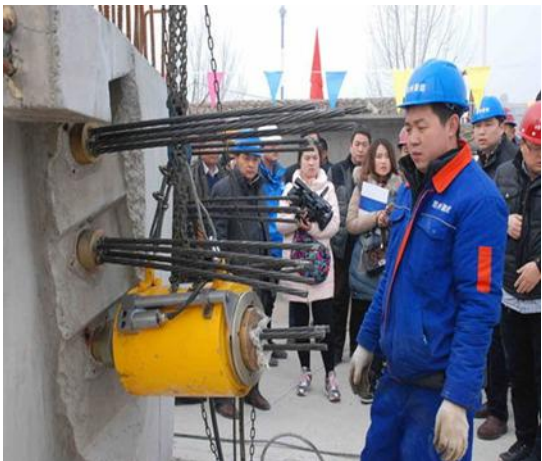
预应力混凝土后张法生产示意图
