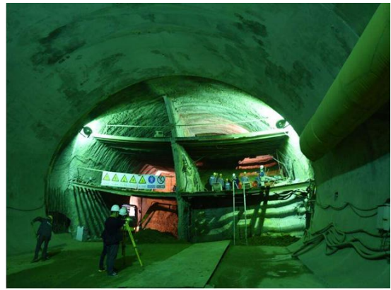
(六) 中隔壁法 (CD 工法) 和交叉中隔壁法 (CRD 工法)
