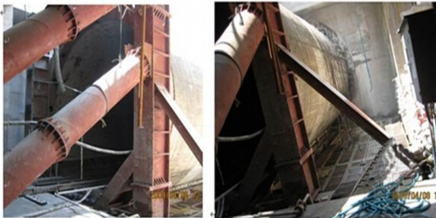
图 3-5 反力架的加固
