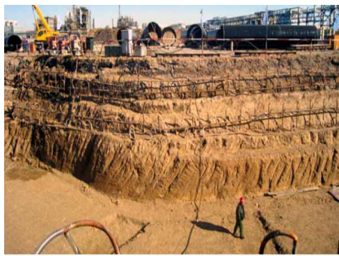
基坑二级轻型井点降水
