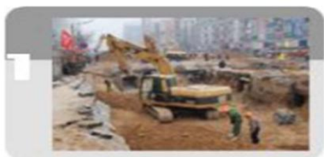
步骤一：封路、挖运土方至顶板标高
