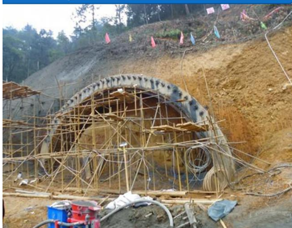
9.管棚注浆后封孔:
