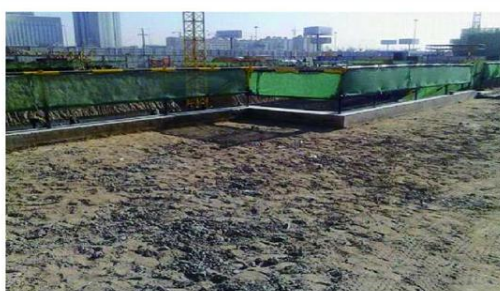
基坑顶部防淹墙1
