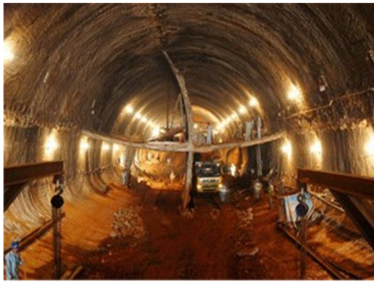
(六) 中隔壁法 (CD 工法) 和交叉中隔壁法 (CRD 工法)
