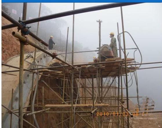
9.管棚注浆后封孔:
