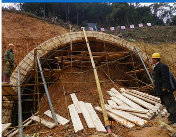
5.套拱模板加固及泵管安装
