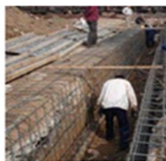
导墙钢筋绑扎
