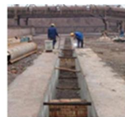
导墙结构支撑
