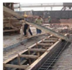
导墙混凝土浇筑
