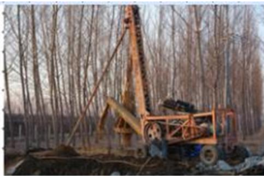
冲击钻法施工
