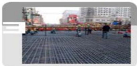
步骤三：工程顶板钢筋绑扎施工
