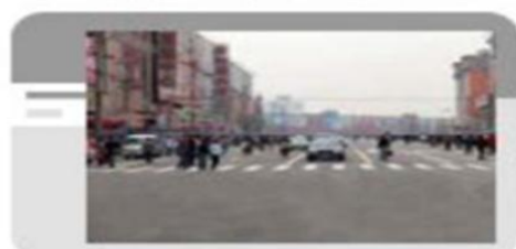
路面工程完成恢复市政交通
