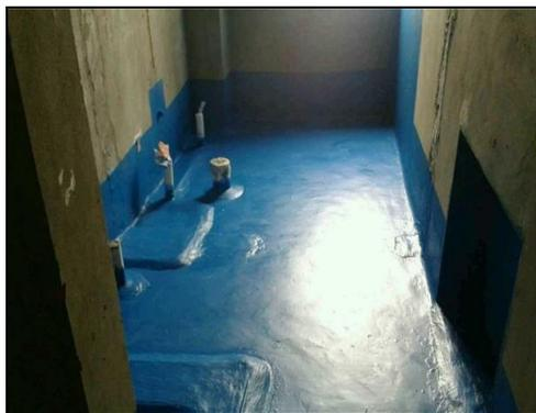
(4) 转角、变形缝、施工缝、穿墙管等增加胎体增强材料或增涂防水涂料，宽度 $\geq$ 50mm；
