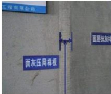
(4) 滴水线应整齐顺直，滴水线应内高外低，滴水槽的宽度和深度均不应小于 10mm。
