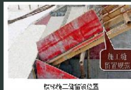
拟设施工缝留置位置
