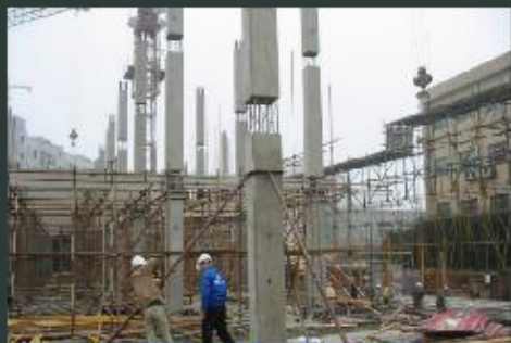
预制柱吊装、支撑
