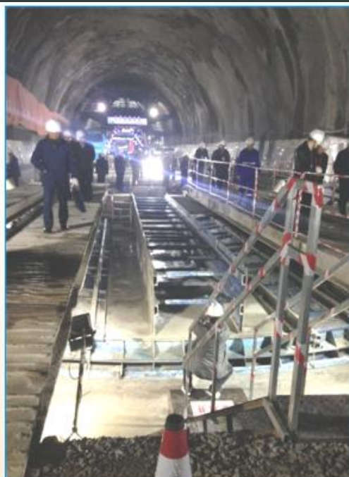
衬砌施工成套设备
