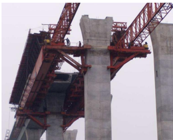
图5.53 移动模架断面结构示意图
