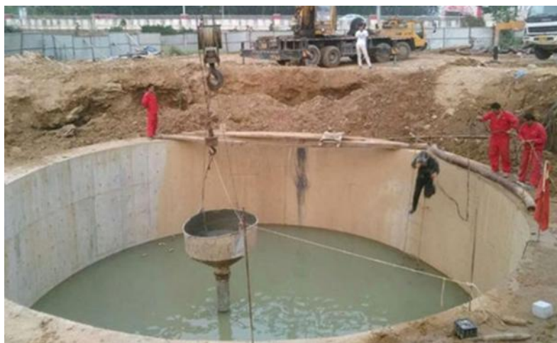
1B413044 地下连续墙施工
