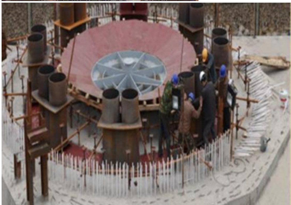
转体到位固结后 将上下转盘连接钢筋进行焊接
