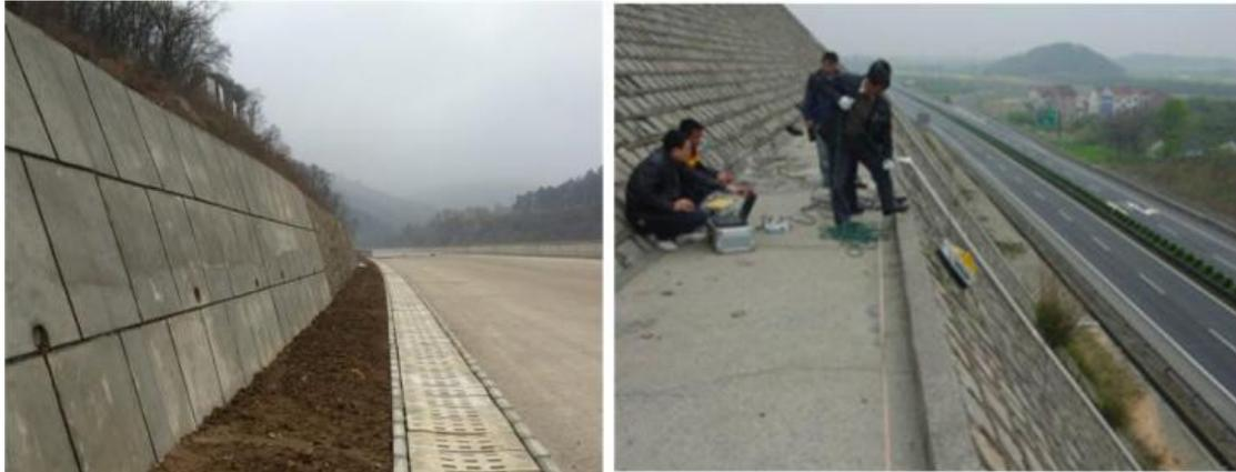
碎落台指的是在路堑边坡坡脚与边沟外侧边缘之间或边坡上,为防止碎落物落入边沟而设置的有一定宽度的纵向平台。
