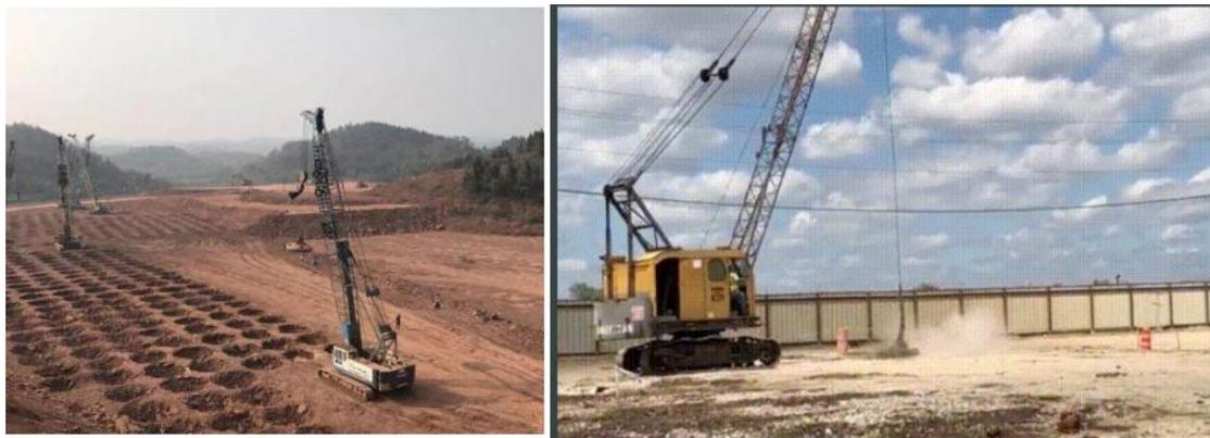
强夯置换法适用于处理高饱和度的粉土与软塑、流塑的软黏土地基，处理深度不宜大于 7m。
