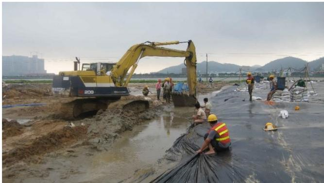
真空预压施工应按排水系统施工、抽真空系统施工、密封系统施工及抽气的步骤进行。当满足下列条件之一时，可停止抽气：
