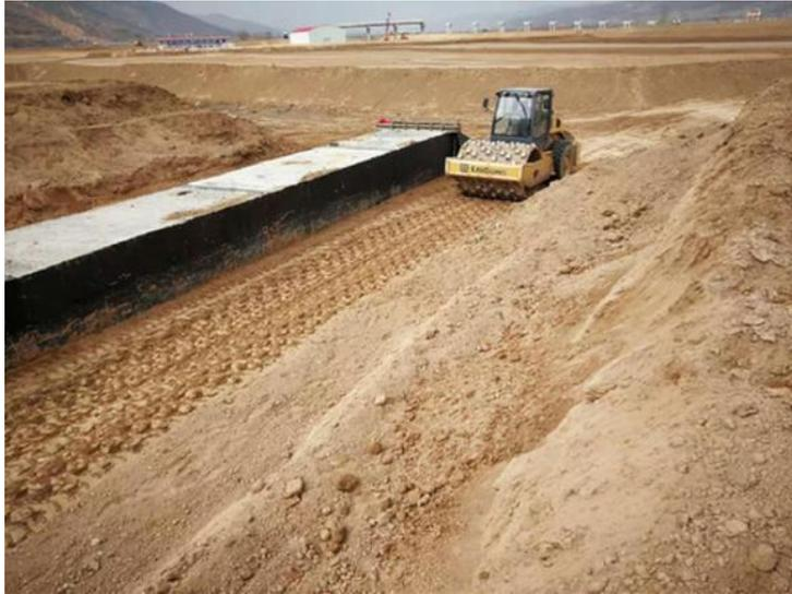
除采用防止地表水下渗的措施外，可根据湿陷性黄土地基工程特性和工程要求，因地制宜采取换填法、冲击碾压法、强夯法、挤密桩法、桩基础法等措施对地基进行处理。地基处理方法均应进行试验段施工。
