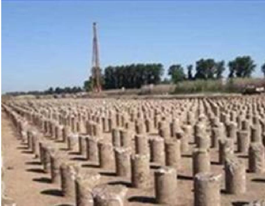
由碎石、砾石、石屑、砂、粉煤灰掺水泥加水拌合，用打桩机制成的桩。
