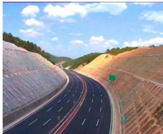
(3) 分段纵挖法：沿路堑纵向选择一个或几个适宜处，将较薄一侧堑壁横向挖穿，使路堑分成两段或数段，各段再纵向开挖。该法适用于过长，弃土运距过远，一侧堑壁较薄的傍山
