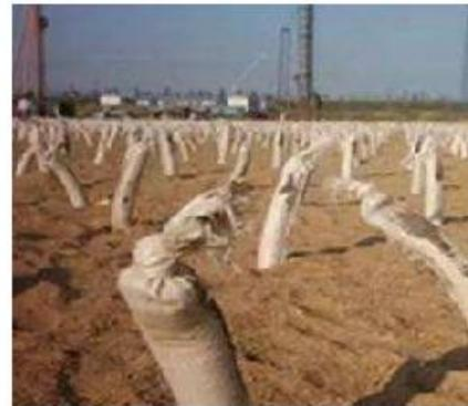
袋装砂井和塑料排水板可采用沉管式打桩机施工，塑料排水板也可用插板机施工。
