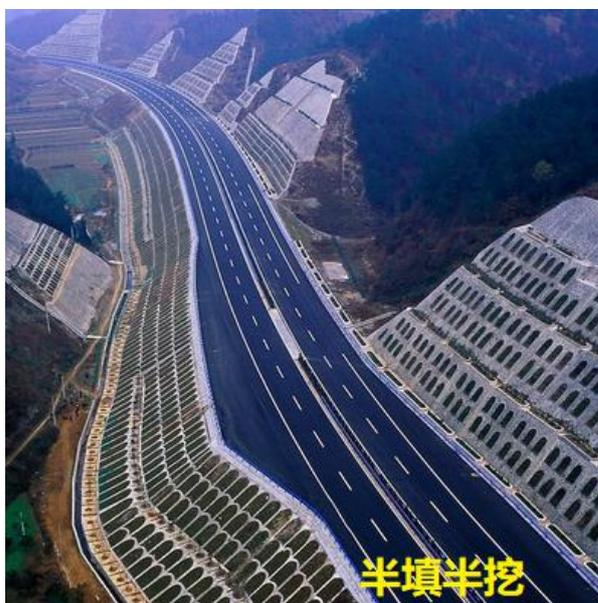
(2) 多层横向全宽挖掘法：从开挖路堑的一端或两端按断面分层挖到设计标高，适用于挖掘深且短的路堑。
